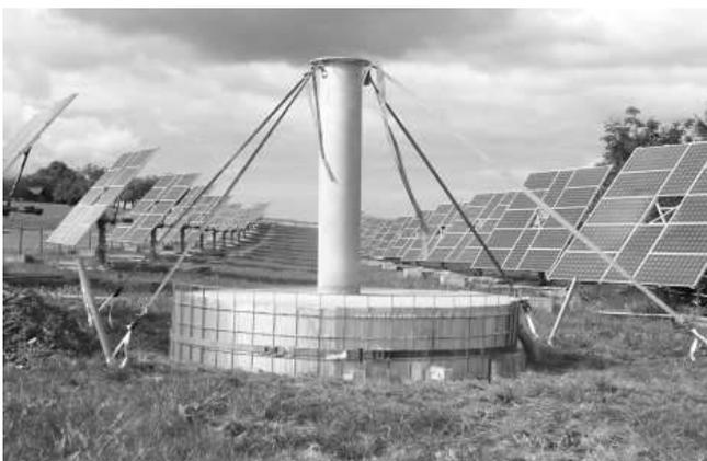
Mastquerschnitt:  $D = 219,1 \times 7,1\text{mm}$
