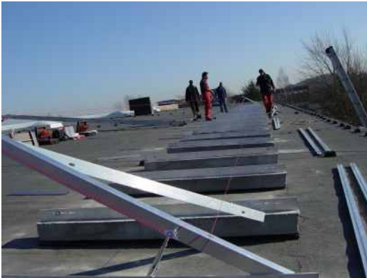
Bodenprofile auf Gewichte verschraubt
