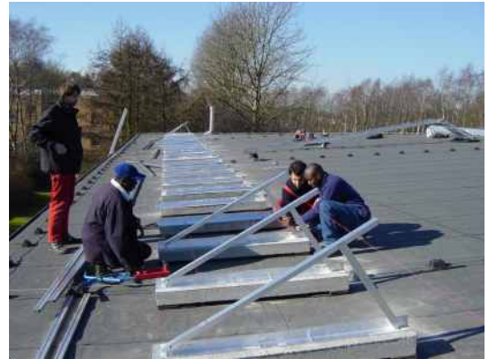
Montage der Dreiecke
