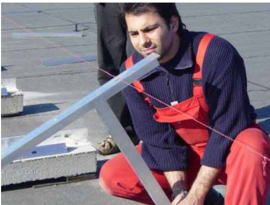
Höhenausrichtung anhand Mauerschnur
