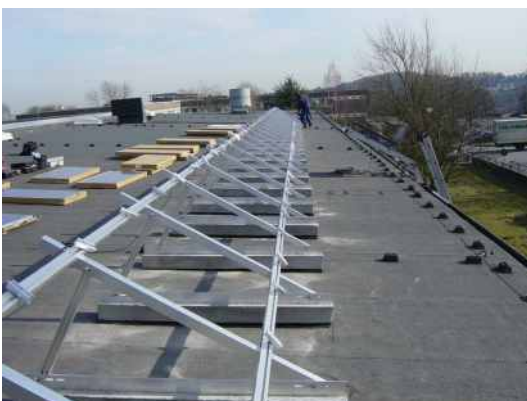
Vormontage der Modulklemmen
