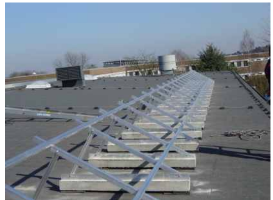
Montage der Oberprofile
